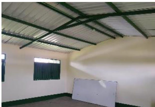
Foto 1. Instalación de estructura metálica
