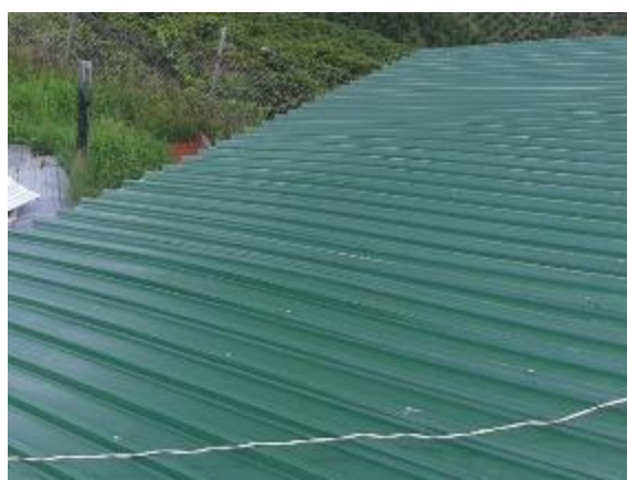
Foto 2. Instalación de teja termo acústica UPVC
